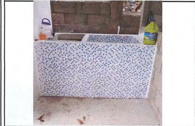
Foto 3: MEJORAMIENTO DE PILA
